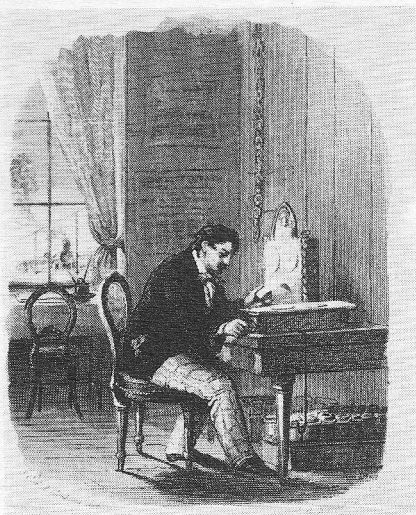
Wijzertelegraaf in gebruik bij de H.Y.S.M. De telegrafist draait aan het krukje tot de gewenste letter is bereikt.
